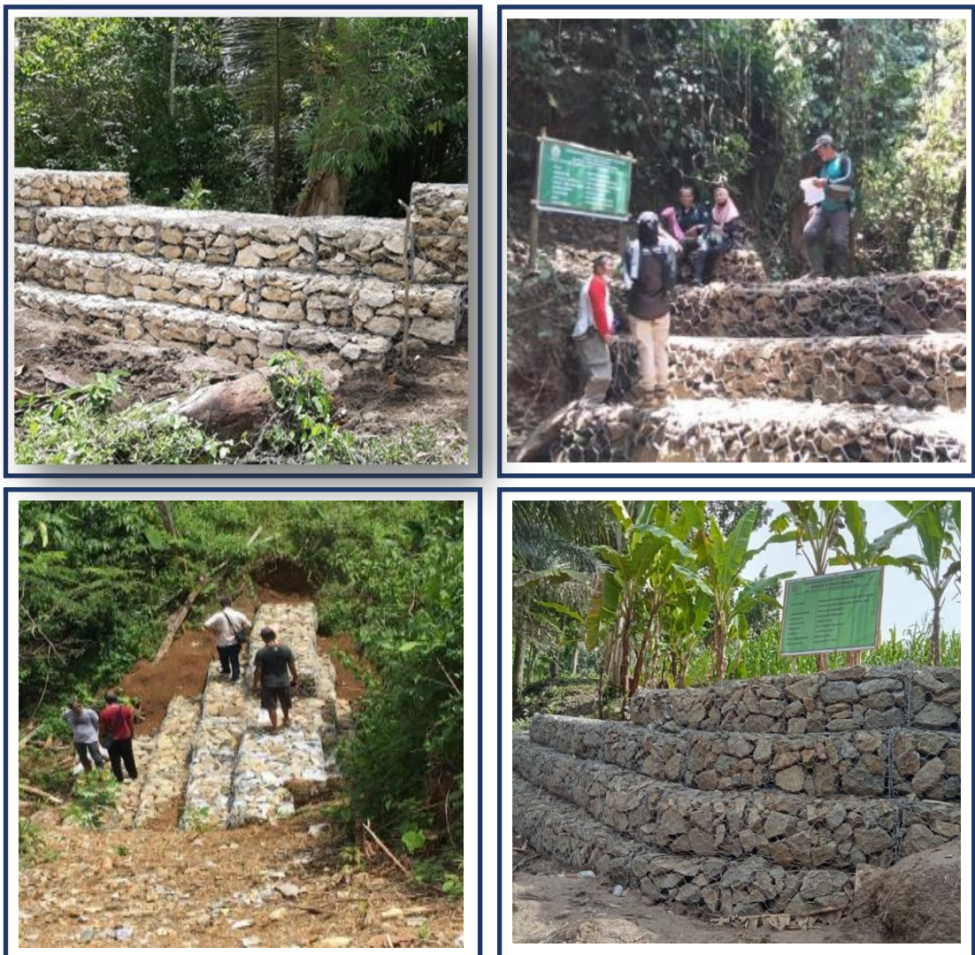
Gambar 18. Pembuatan bangunan konservasi tanah dan air
